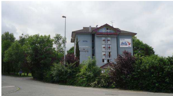
Vue vers le sud depuis la rue du pamphiot Végétalisation de la zone
