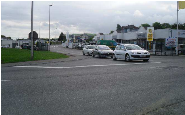
Carrefour de sortie du secteur à l'ouest entre la rue du Pamphiot et la route de Margencel
